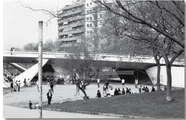
Puente de Felipe II-Bac de Roda. (Fuente: Gaspar Maza.)
