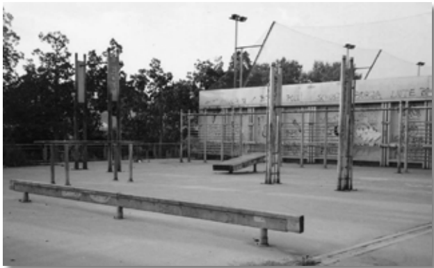
Instalaciones deportivas Bon Pastor. (Fuente: Gaspar Maza.)
